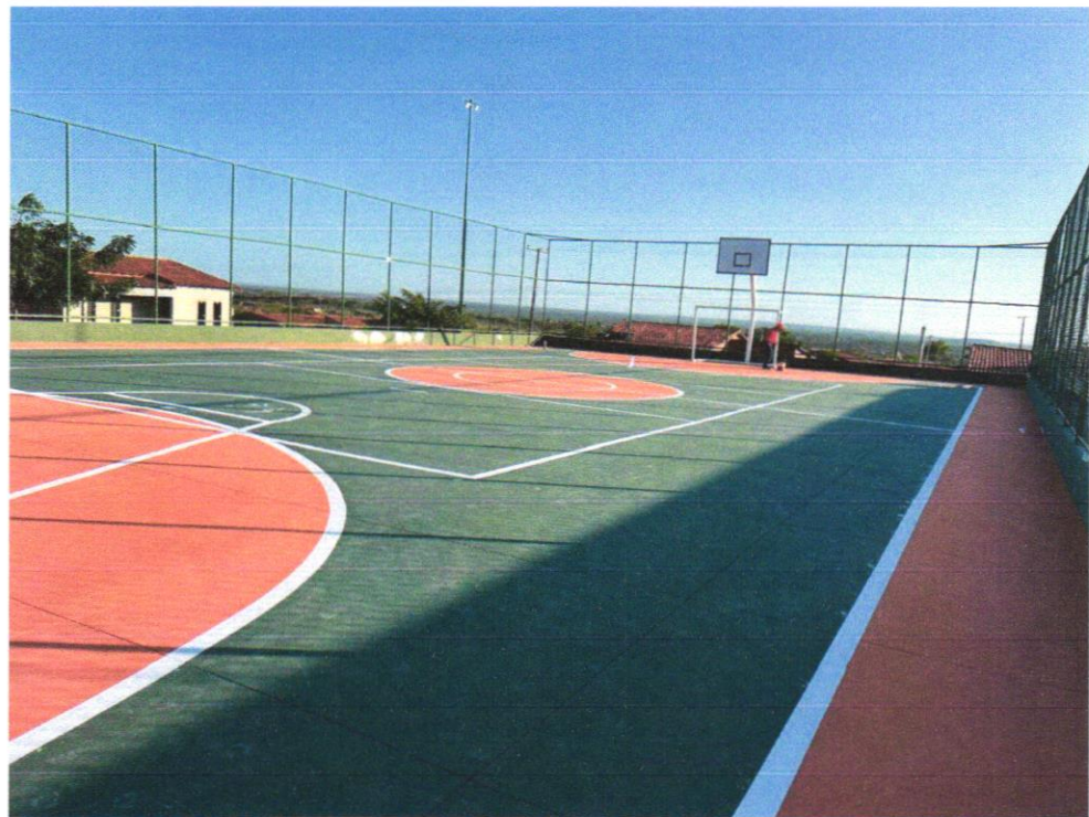
Foto 05 - Estrutura metálica fixa, p/ tabela em aço com aro e cesta p/ basquete, padrão oficial, em tubo galvanizado d=5" - instalada
