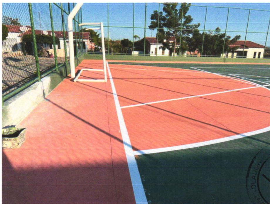
Foto 04- Traves oficial para futebol de salão 3x2m em aço galv.3", com requadro e redes de polietileno fio 4mm (conjunto p/futsal)
